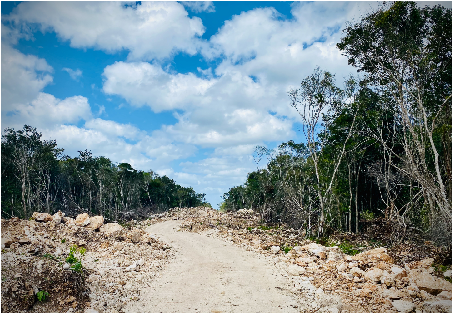
Abholzung für den Bau der Maya-Bahn (Foto: @Sanz-Hess)
