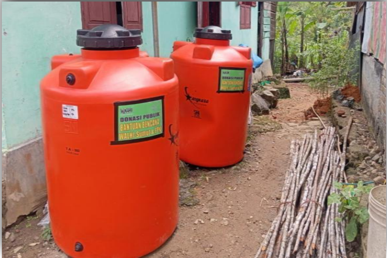
Wasserspeicher für das Dorf Bonan Dolok, im Landkreis Sitahuis, Bezirk Humbang Hasundutan.
