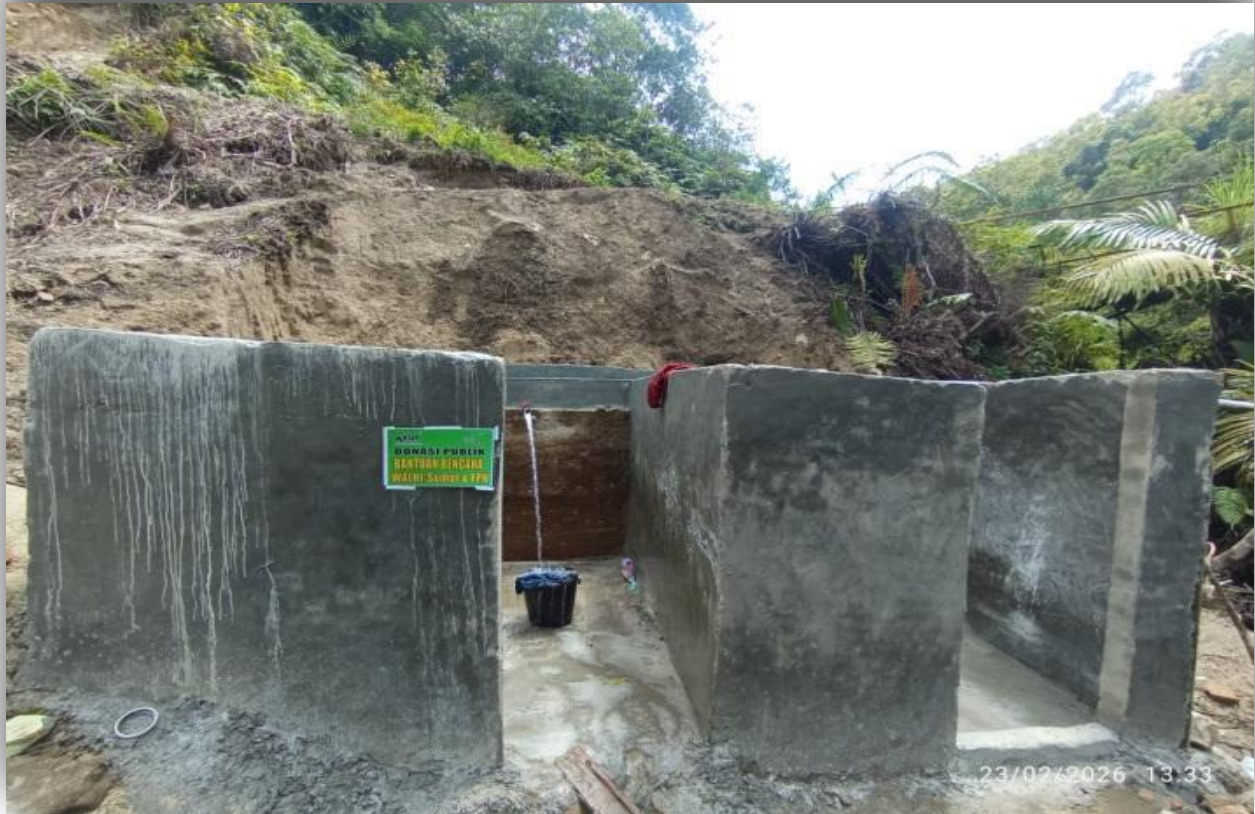
Bau eines Wasserspeichers im Dorf Sitapongan, Landkreis Sijamapolang, Bezirk Humbang Hasundutan
