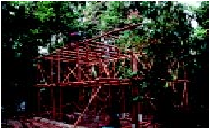
Die erste Hütte für Ökotouristen wird gebaut.
